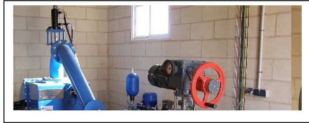
Fig. 2. Conjunto turbina-generador.
