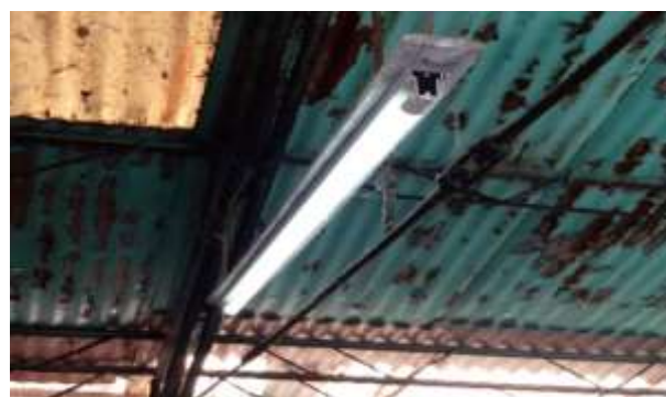
Figura 3. Lámpara LED 18 W de corriente alterna encendida
